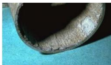
Gambar II.5 Korosi Intergranular Pada Pipa
