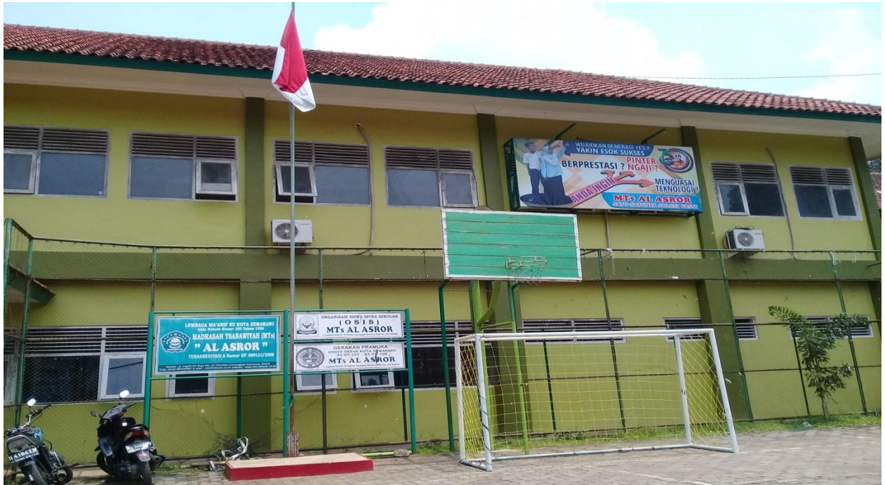
Gambar bangunan MTs Al Asror Semarang
