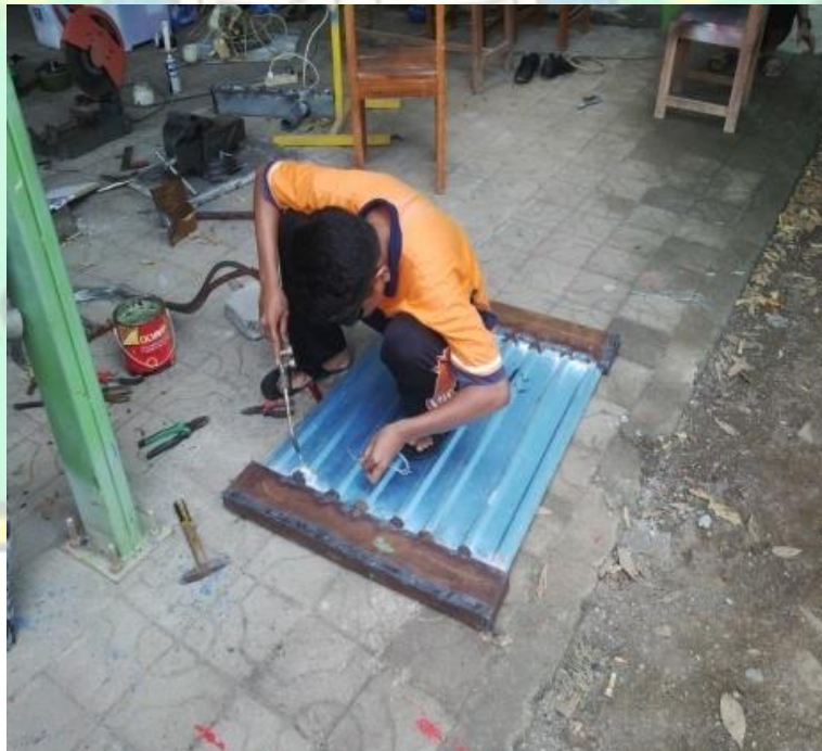
Pengelasan Pipa Kolektor Dengan Header
